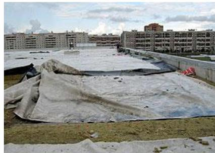
Ветер, проходящий над зданием с плоской крышей и вокруг него (рис. 3), создает положительное давление на наветренную стену, отрицательное давление (разрежение) на подветренной стене и стенах, параллельных направлению потока, и всасывание на большей площади крыши. Крыши с плоскими профилями и низкими парапетами, испытывают сильное давление всасывания, локализованное по периметру крыши (рис. 2а, 2б).
